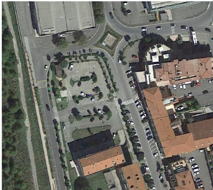
Fig. 4.6.10b - Il parcheggio dove poter installare centraline di ricarica di auto elettriche nel Comune di Aulla
